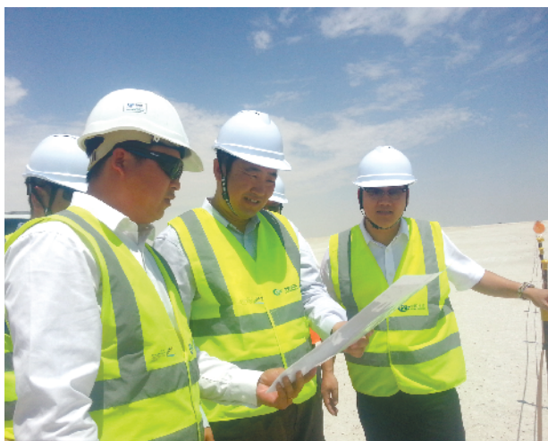
■梁卓仁(中)深入地处非洲的一线建设现场
