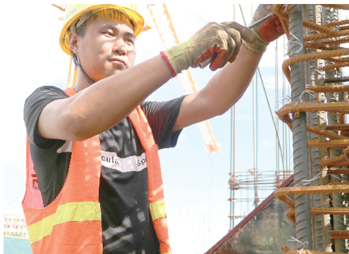
■李强正在进行墙柱钢筋绑扎作业 周礼雄/摄
