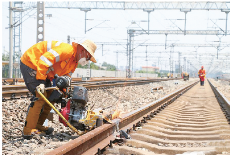
▲在京沪铁路沿线的晏城站,济南铁路局济南工务段的铁路焊轨工在高温下作业
