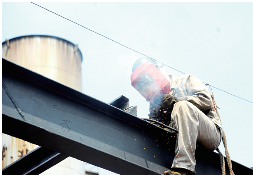
■工人坐在钢梁上焊接作业
