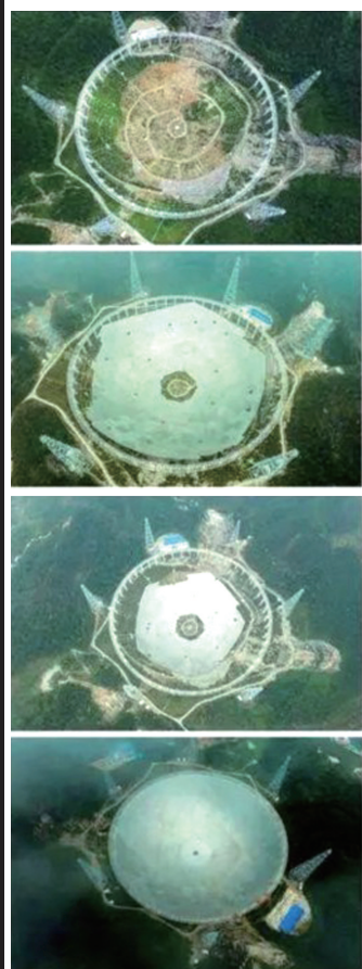
FAST项目从安装第一块反射面板到即将完成的过程。
