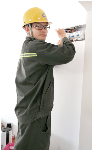
■正在维修的杨辉 唐洁容/摄
