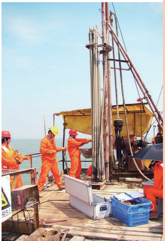
物探队承担完成港珠澳大桥前期勘察项目,图为工作人员开展海上物探勘察 黄富友/摄
