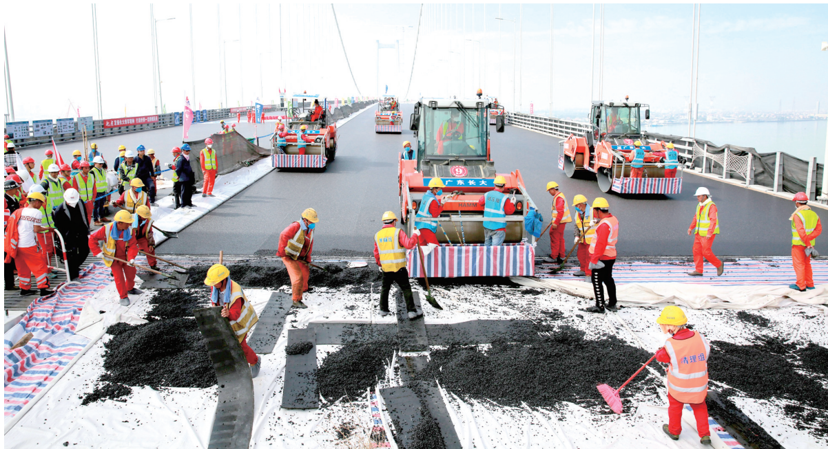
重点工程劳动竞赛现场,工人们干劲十足!
