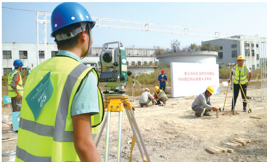
▲测量放线工实操现场
