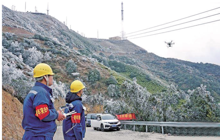
■1月8日,南方电网广东电网公司云浮云城供电局来到大金山,对金山站10千伏大蚩山线进行无人机特巡,检查线路及设备覆冰情况 单位供图
