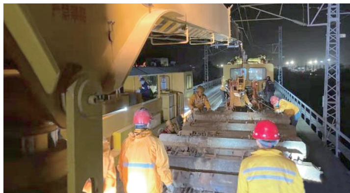
■广州工务段综合机修车间职工在广深I、II线回收旧轨枕
