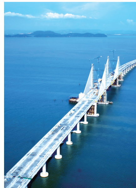
■中交四航局一公司承建的马来西亚槟城二桥
