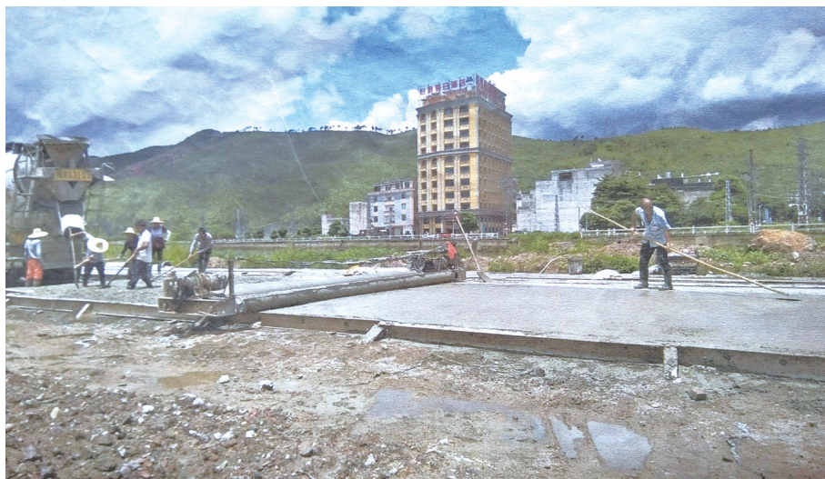
▲陈先生曾参与建设的河源市连平县忠信新邨沿江路市政工程项目
