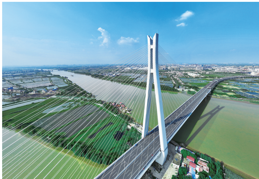
■南中高速洪奇门特大桥。
